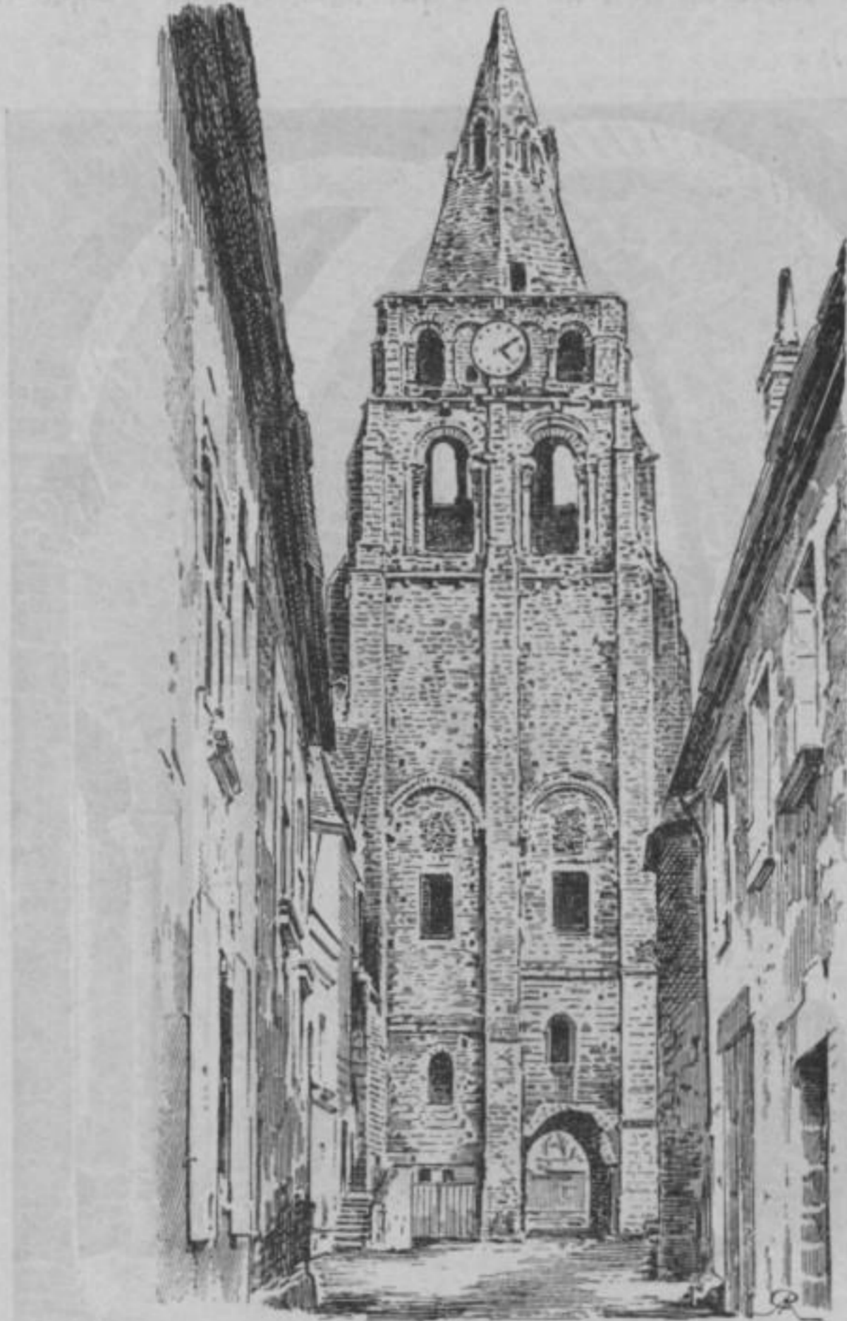
Fig. 6. — Église abbatiale de Cormery. Tour Saint-Paul. État ancien.
